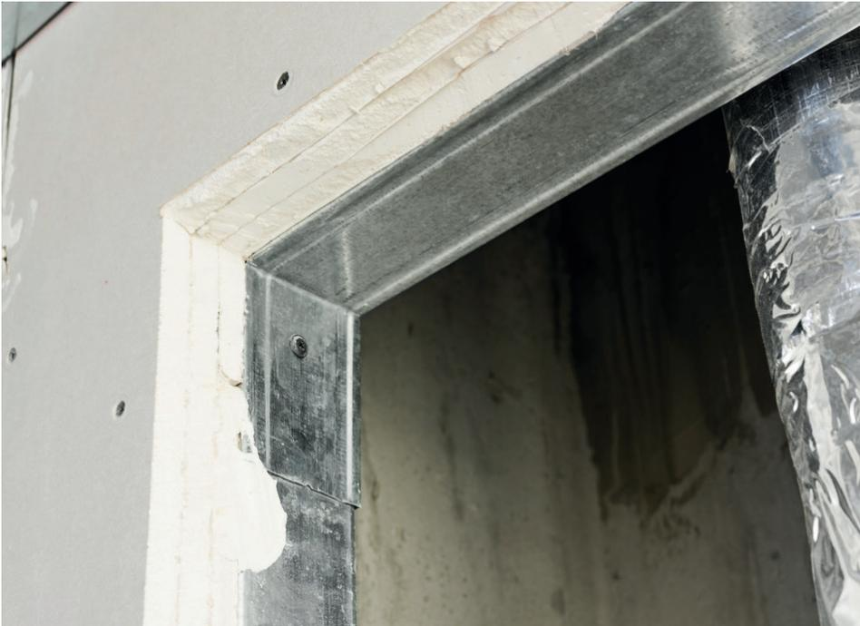
Schachtwandkonstruktion, 3-fach beplankt, Leibung ohne Beplankung
