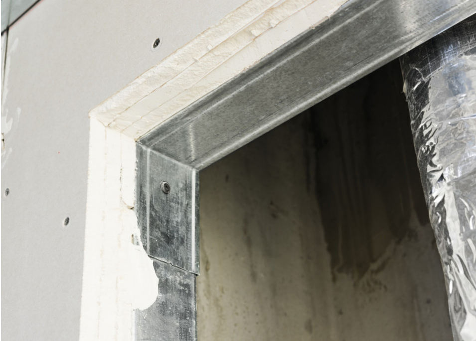
Schachtwandkonstruktion, 3-fach beplankt, Leibung ohne Beplankung
