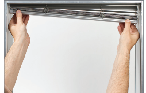
Ausrichten des Lamellenpakets
