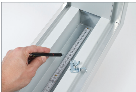
Befestigungspunkte im Jalousiekasten anzeichnen
