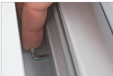
Jalousie einsetzen und Deckträger verriegeln
