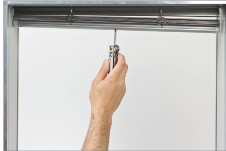
Lösen der Schnurbremse
