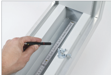
Befestigungspunkte im Jalousiekasten anzeichnen
