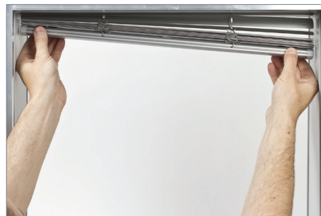
Ausrichten des Lamellenpakets
