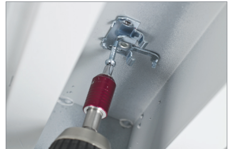
Deckenträger anschrauben
