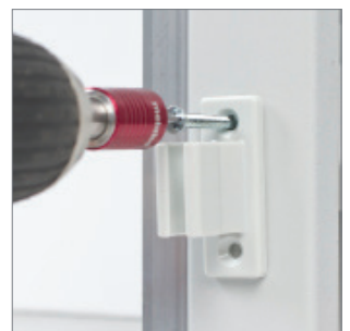
Kurbelhalterung verschrauben
